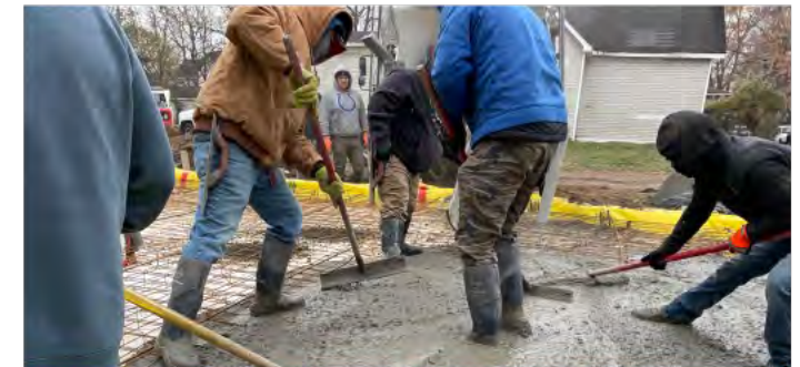
Concrete Pour Over Rigid Insulation
